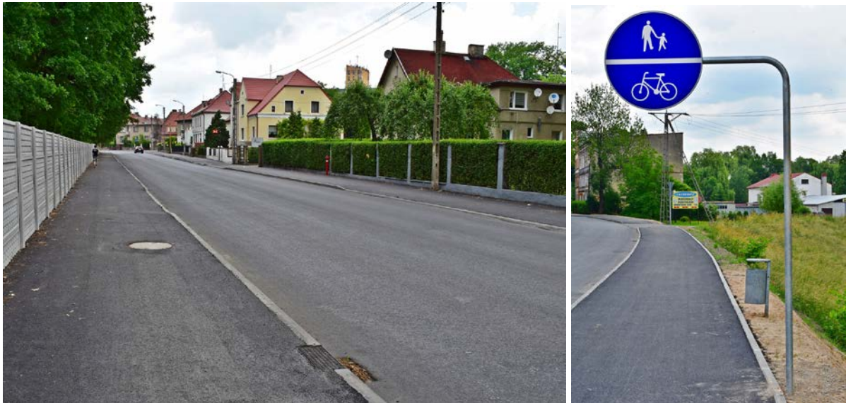
Remont ul. Kolejowej w Prudniku
