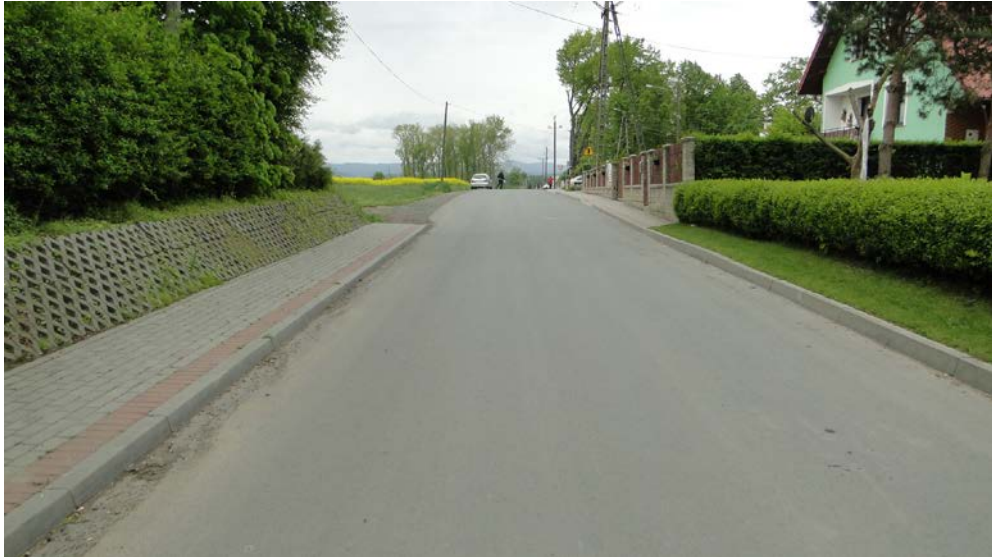
Przebudowa ul. Harcerskiej w Lubrzy
