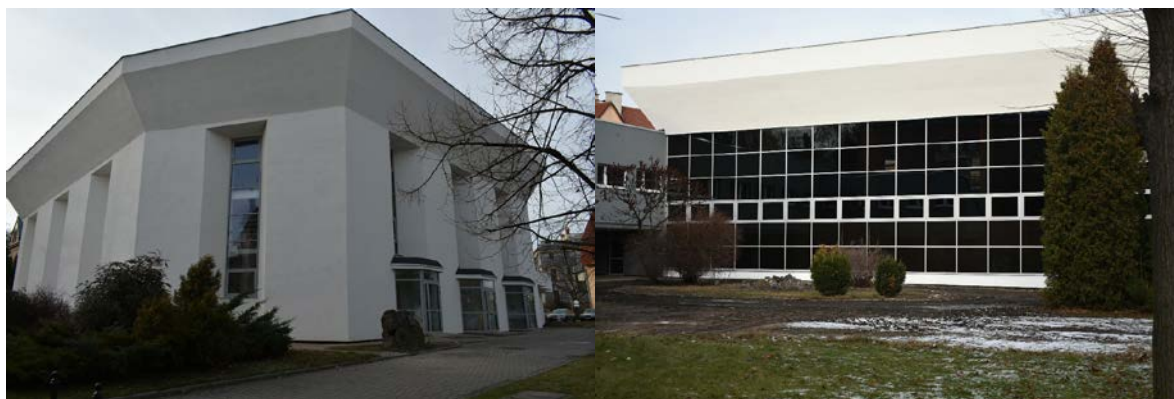
Sala gimnastyczna ZSO nr 1 w Prudniku po termomodernizacji
