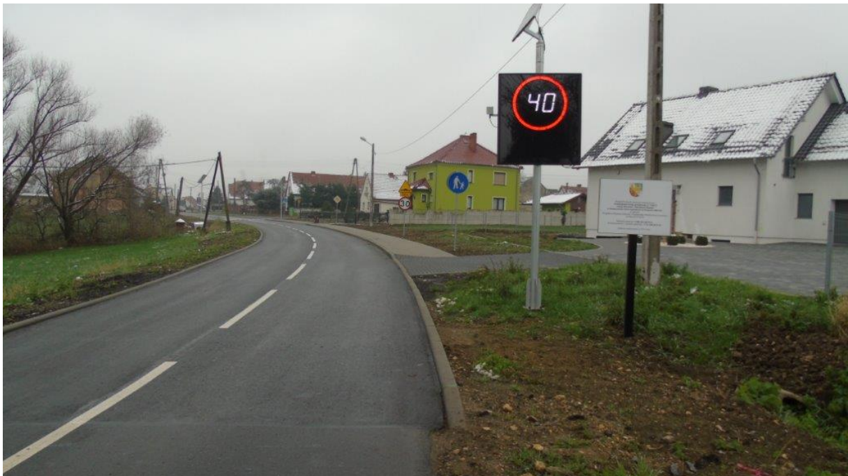
Przebudowa drogi na odcinku Dzierżysławice – Raclawice Śląskie- etap I
