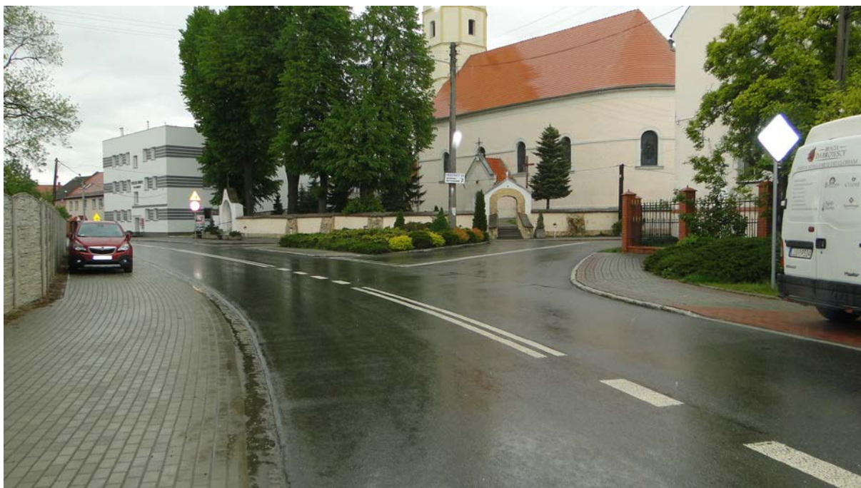
Przebudowa ul. Wolności w Lubrzy
